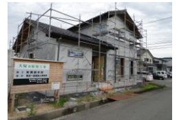
新築住宅 (建設中)
